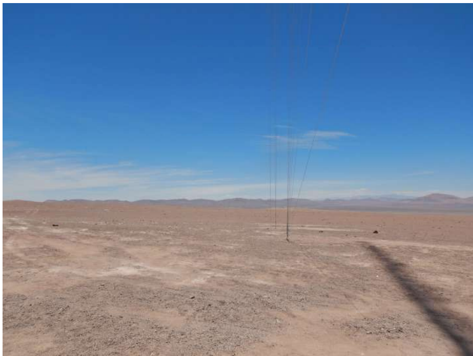
Fotografía desde la torre, dirección Sureste.
