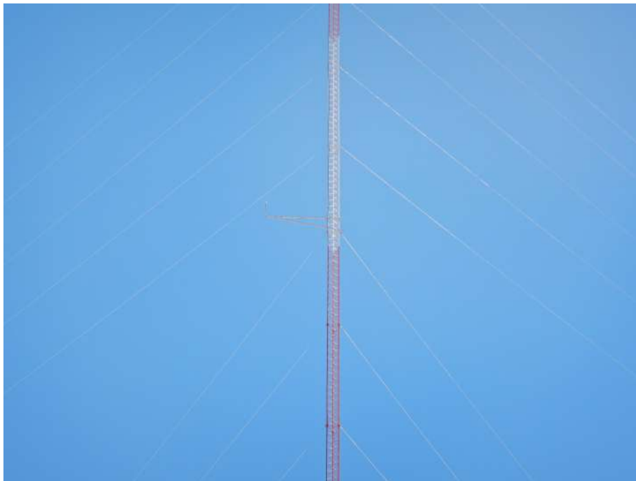
Fotografía nivel medio superior de torre hacia el sur
