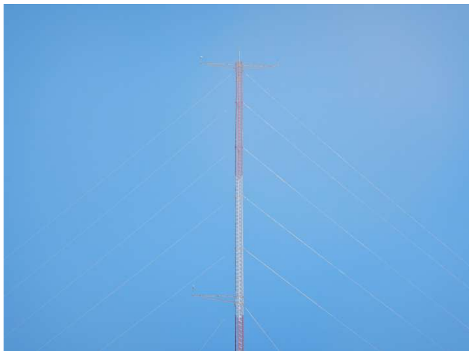
Fotografía nivel alto y medio superior de torre hacia el sur
