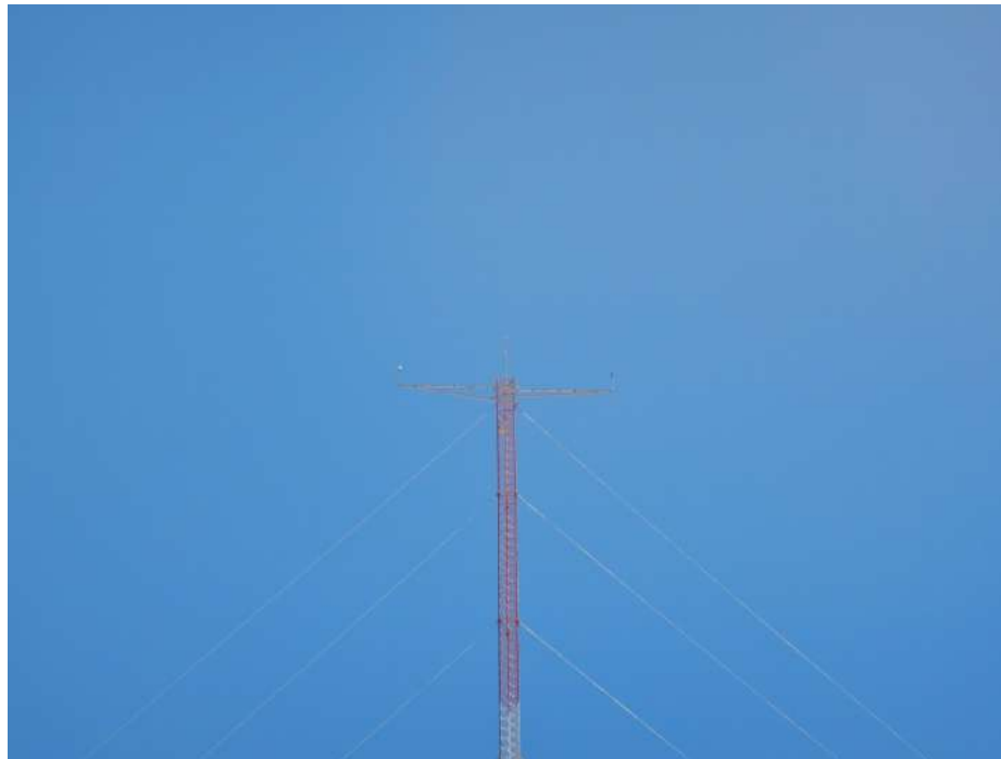
Fotografía nivel alto de torre hacia el sur
