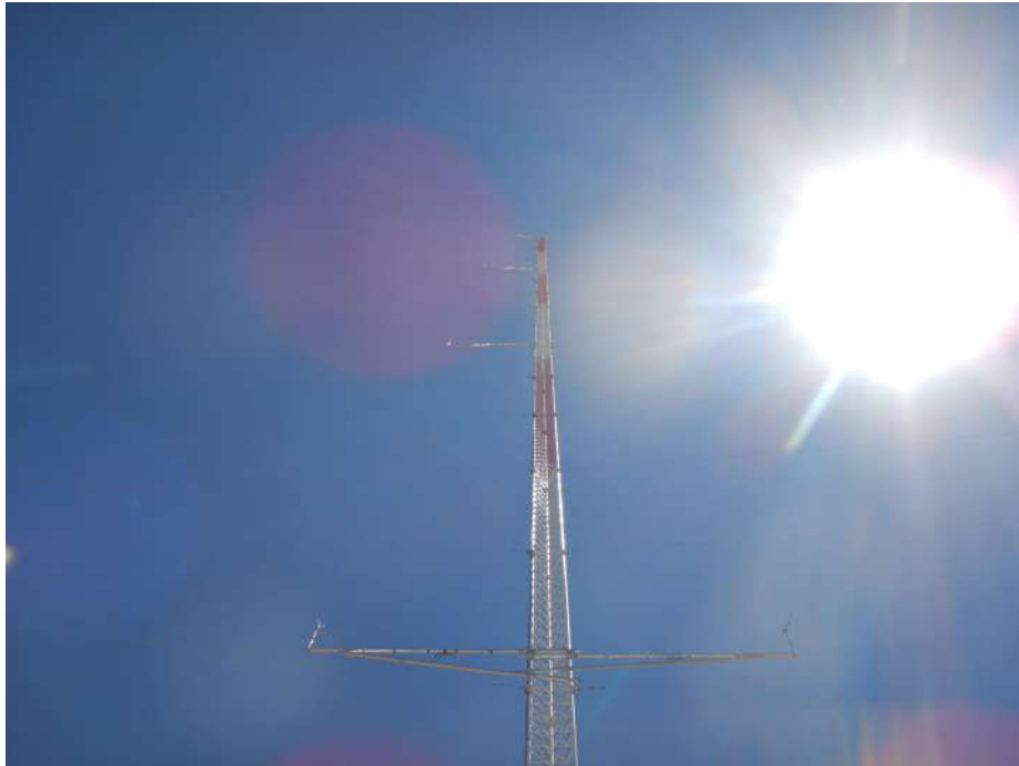
Fotografía desde base de torre hacia el norte
