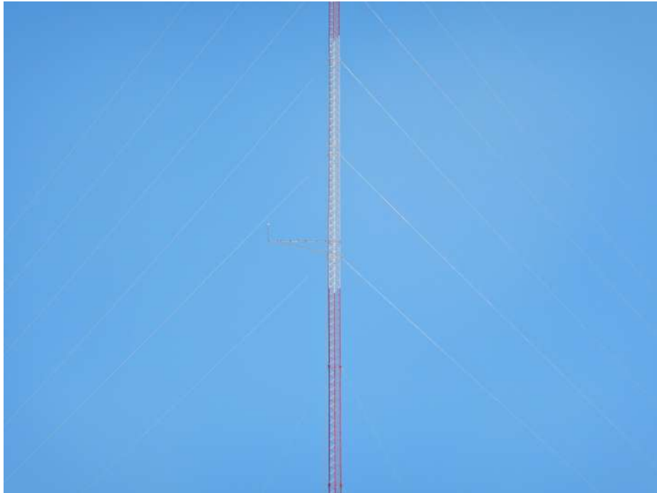
Fotografía nivel medio bajo de torre hacia el sur
