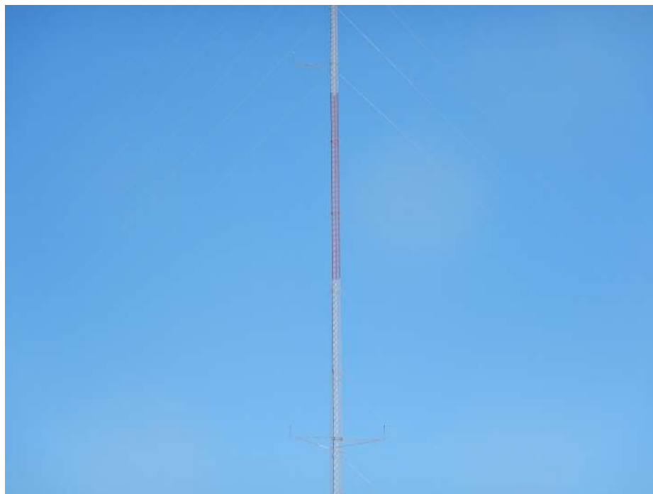
Fotografía nivel medio inferior y bajo de torre hacia el sur
